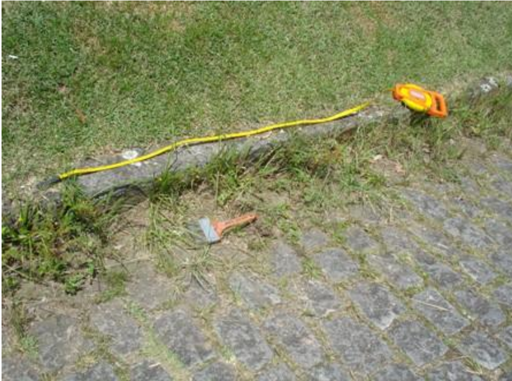
Figura 5.6 – Presença de vegetação entre os espaços dos paralelepípedos (Ponto P1.1)
