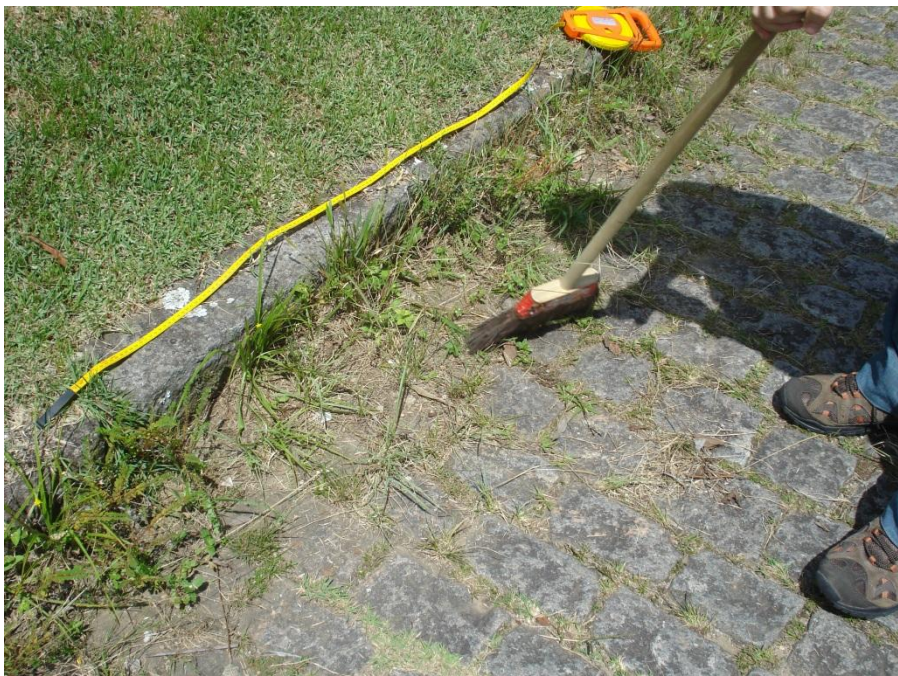
Figura B.2 - Na via da esquerda, paralelepípedo intercalado com gramineas com maior presença destas na sarjeta.
