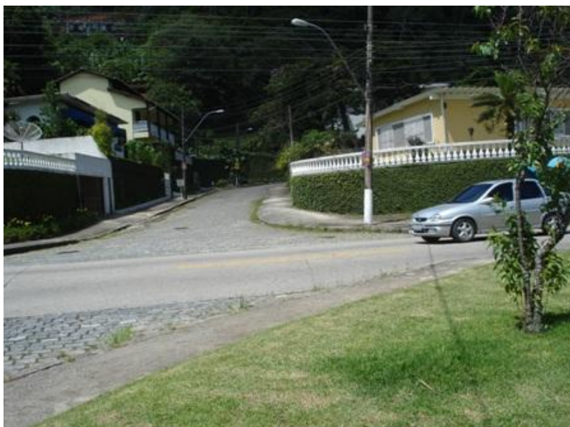
Figura 5.5 – Diferença de pavimento no ponto 1
